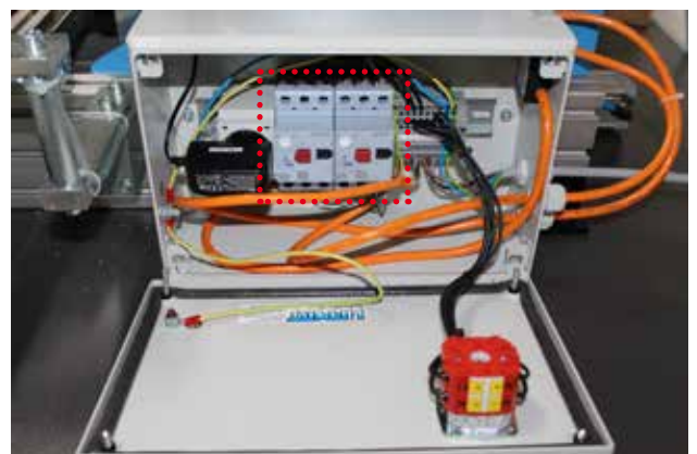
Abb.: Motorschutzschalter
