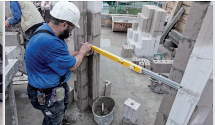
Dank des Teleskopsystems kann der Handwerker die Wasserwaage genau auf die Länge einstellen, die er bei einer Messaufgabe braucht.
