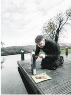
Warum sieht man eigentlich so oft Edelstahlelemente mit Rostbefall? Ein Grund: Häufig wird mit Werkzeug aus "normalem" Stahl verschraubt, was Fremdrost erzeugen kann. Das ist ärgerlich. Wir waren überzeugt, dass man das verhindern kann. Durch Schraubwerkzeuge, die ebenfalls aus Edelstahl sind und die notwendige Industriestandard-Härte haben. Fremdrostbefall wird verhindert, eine spezielle Vakuummeishärtung sorgt für die notwendige Härte. In VDE-Ausführung.
